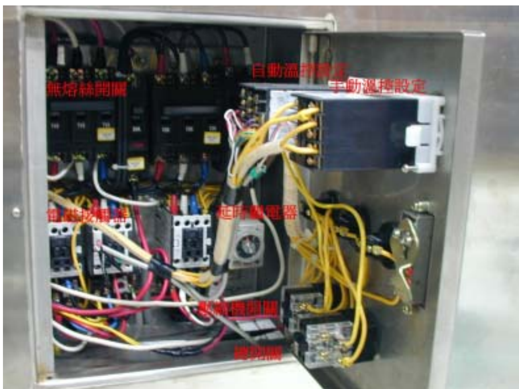
圖三 冰水機電路
